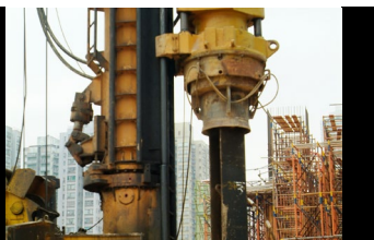
在建築工地內使用撞擊式打樁或板樁的機器 The use of percussive pile or metal plank driving on construction sites
